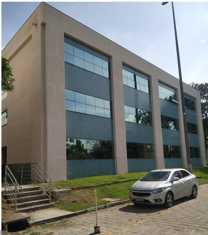
Prédio Luísa Lopes
